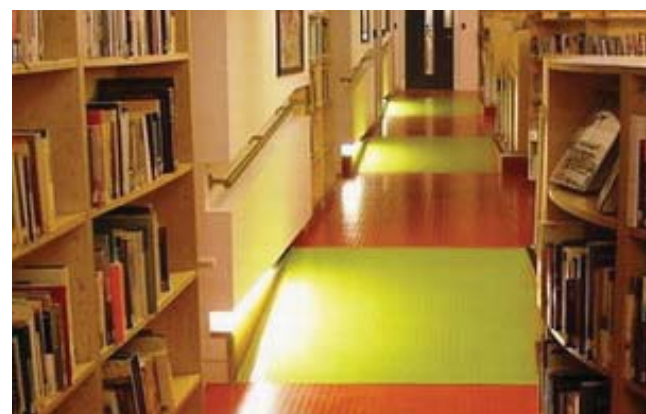
Ensfarget gulv viser hvor gulvet skråner i et skolebibliotek.
